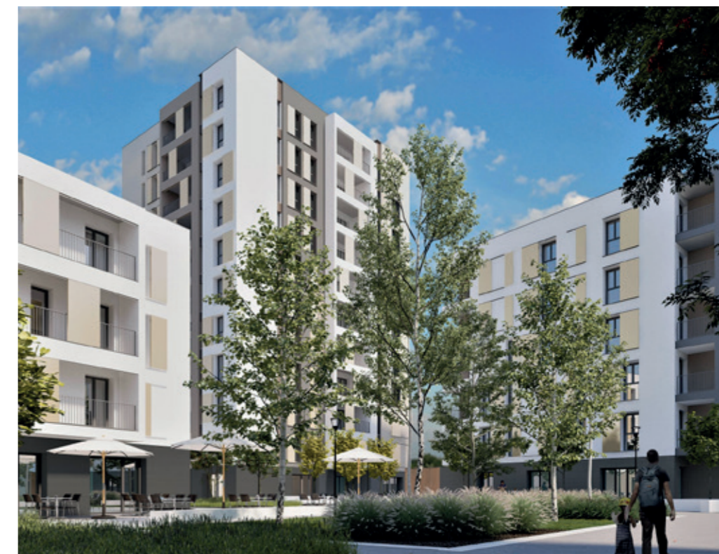
Projeto em andamento
